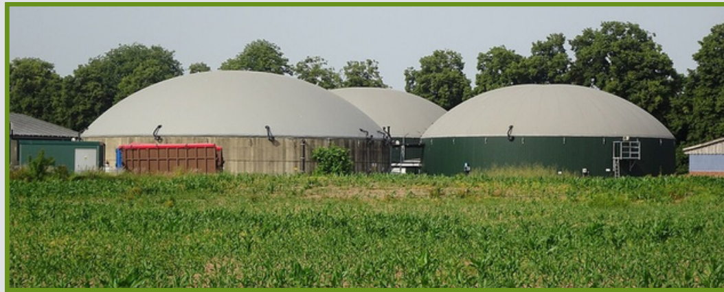
Planta de producción de biogás. Imagen por: Pieter Delicaat - Trabajo propio, CC BY-SA 4.0, vía commons.wikimedia.org
